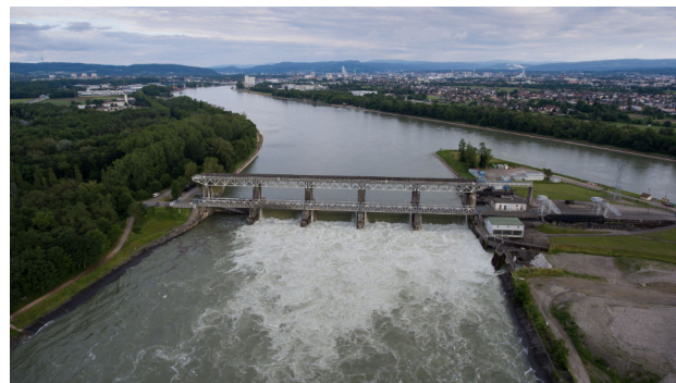
Stauwehr Märkt des Wasserkraftwerks Kembs (Foto: Thomas Berwing; ©: https://creativecommons.org/licenses/by-sa/4.0/ ).
