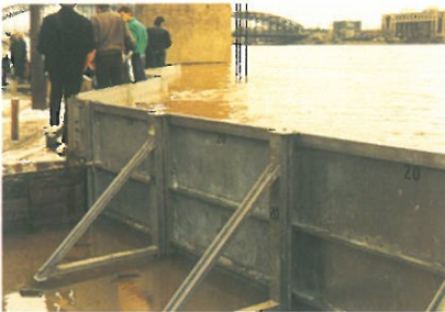
Mobile Schutzwand in der kölnen Altstadt am 28./29.3.1988. Foto Günther Lamek, Koblenz.
