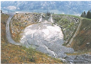
Collecteur de charriage de fond Schipfenbach, Reusstal
