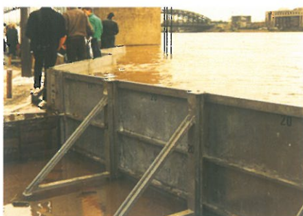
Panneau mobile pour protéger le vieux centre de la ville de Cologne les 28 et 29 mars 1988. Photo Günther Lamek, Coblenz.
