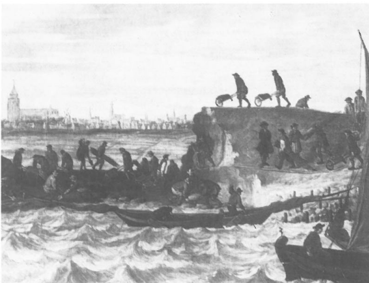
Bild 5.6–2 Instandsetzung eines Deiches nach Sturm- flutschaden im Delta- gebiet bei Zierikzee
