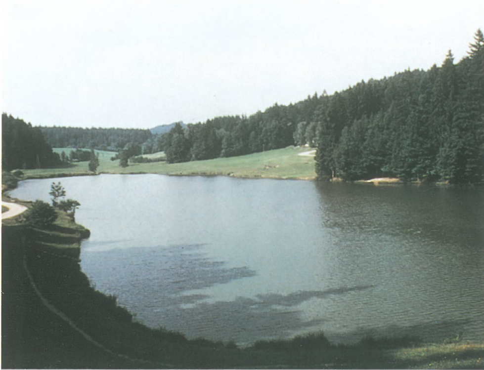
Bild 5.2–24 Ansicht des Hoch- wasserrückhaltebek- kens Reichenbach im Leingebiet
