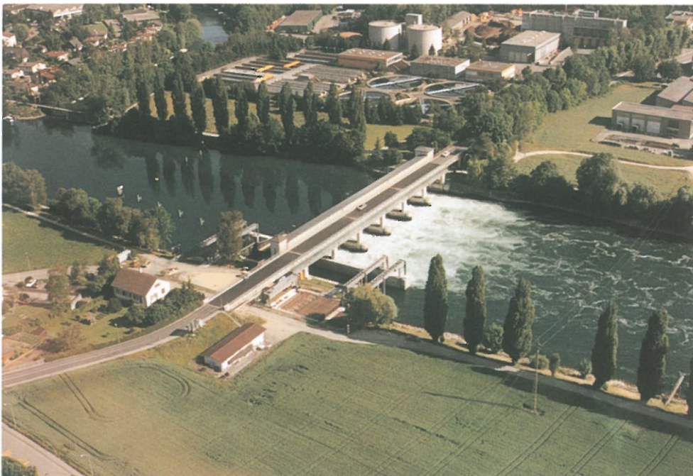
Bild 5.1–7 Das Wehr im Nidau-Büren-Kanal bei Nidau-Port zur Regulierung der Wasserstände in den drei Seen
