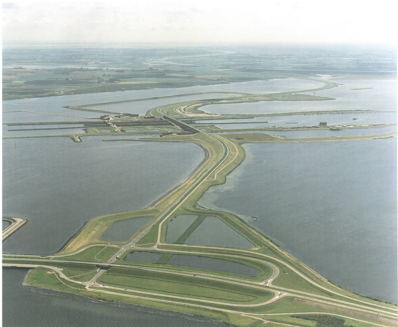
Bild 5.6–22 Krammerschleusen mit Pumpwerken und Speicherbecken für den Sparbetrieb des Süßwassers
