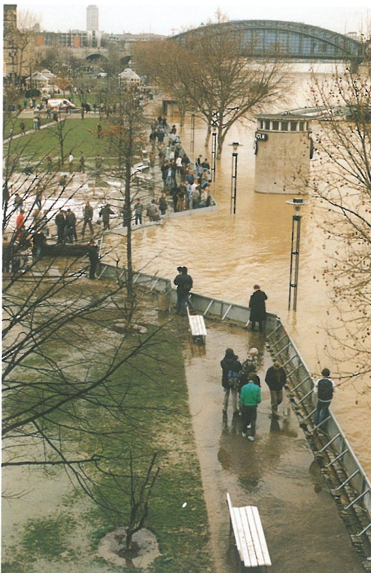
Bild 5.5–7 Transportable Schutzwand in Köln beim Hochwasser im April 1988
