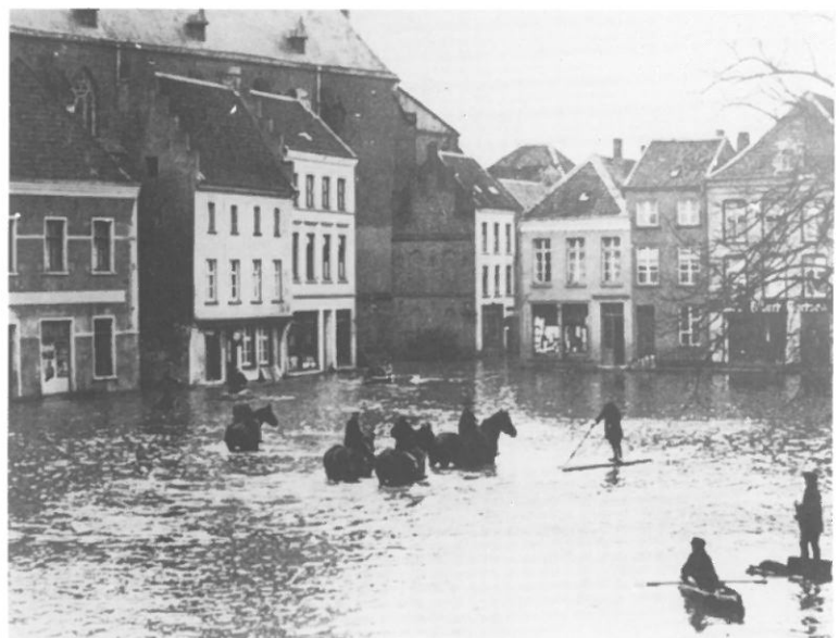
Bild 5.5–1 Hochwasser auf dem Marktplatz von Kalkar am 3. Januar 1926
