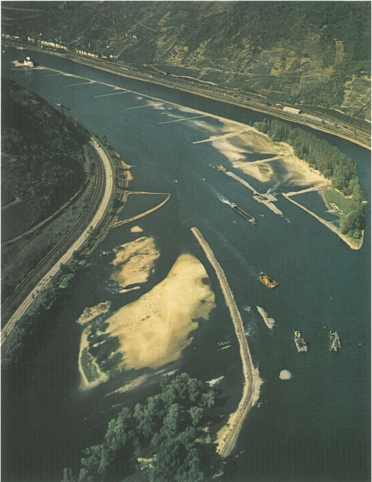
Bild 5.4–22 Bauarbeiten im Wilden Gefähr oberhalb Kaub, Sommer 1976
