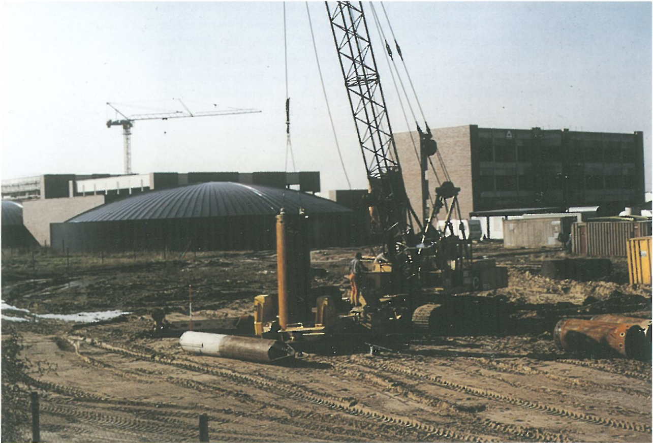
Bild 5.3–19 Rheinwasser-Aufbe- reitungsanlage Bie- besheim im Bau
