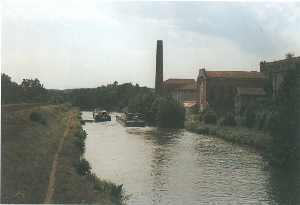
Bild 5.4–34 Der südliche Arm des Ostkanals
