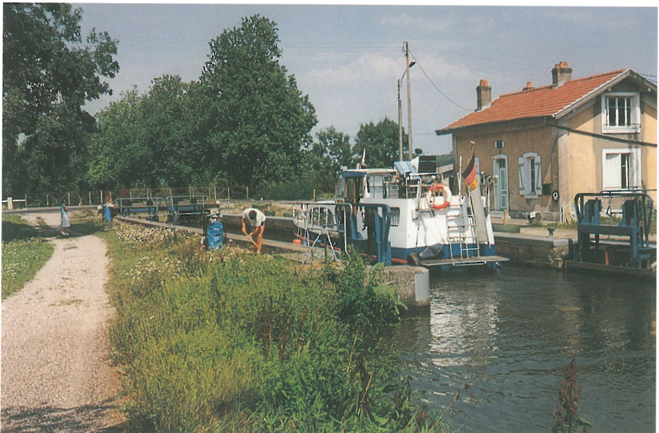
Bild 5.4–35 Schleusung im Hand- betrieb im Ostkanal von Vincey
