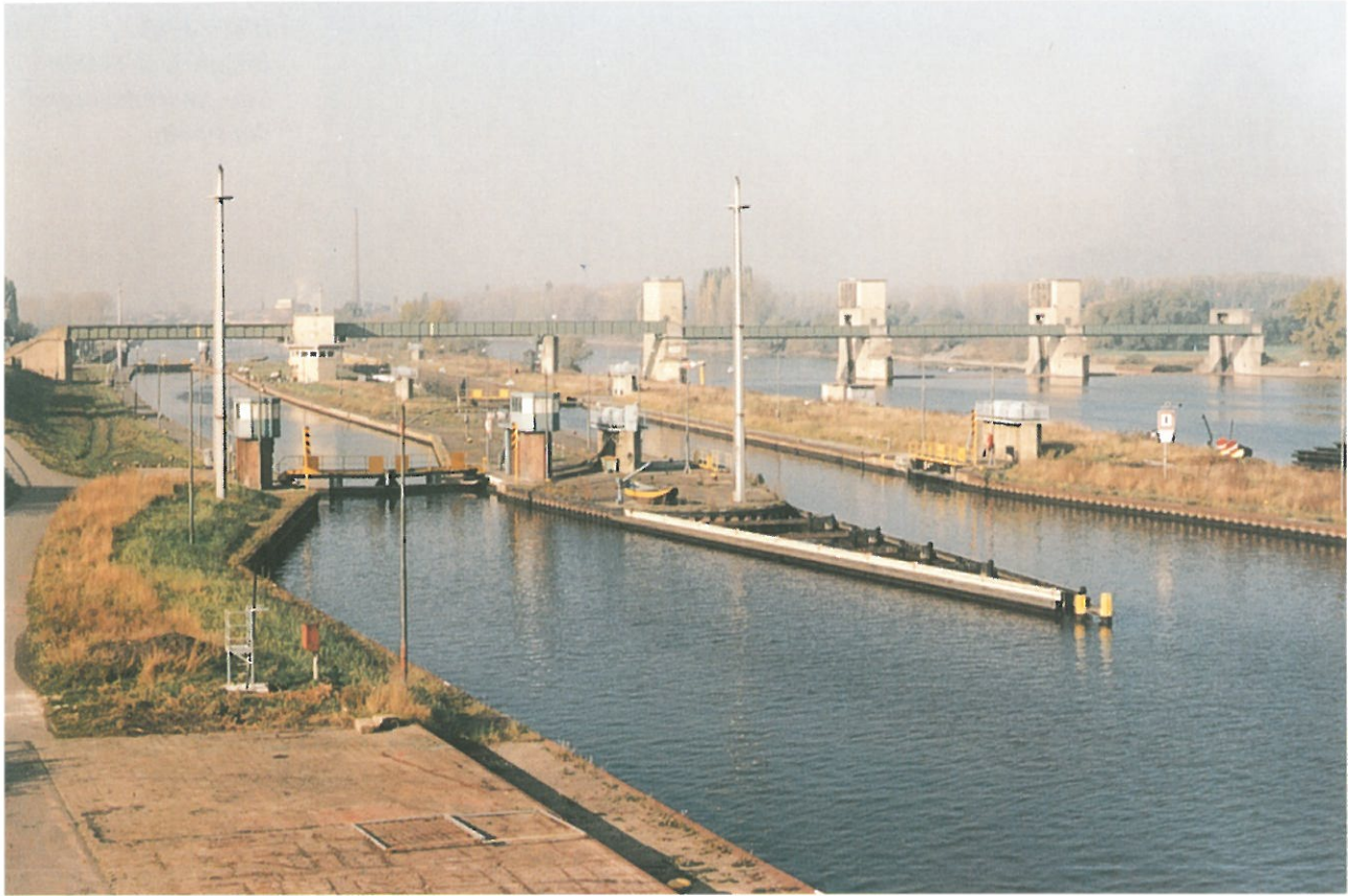
Bild 5.3–21 Die unterste Main- schleuse Kostheim
