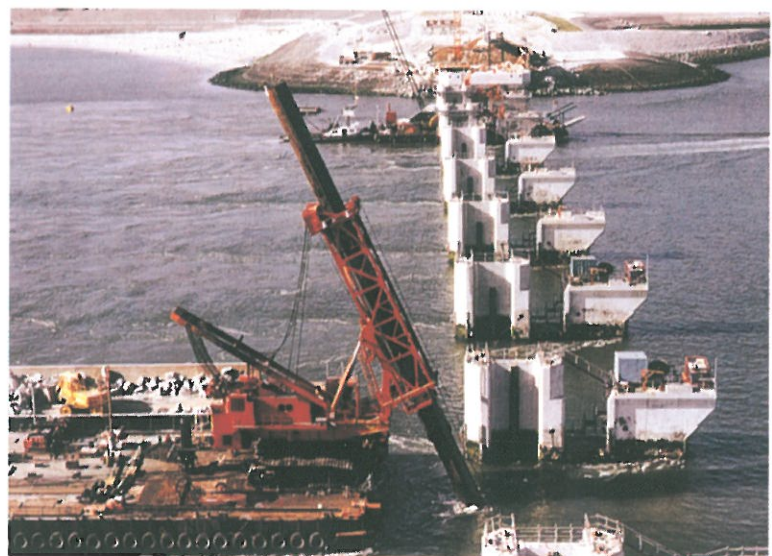
Bild 5.6–21 Schützenanlage des Oosterschelde- Sperrwerkes im Bau
