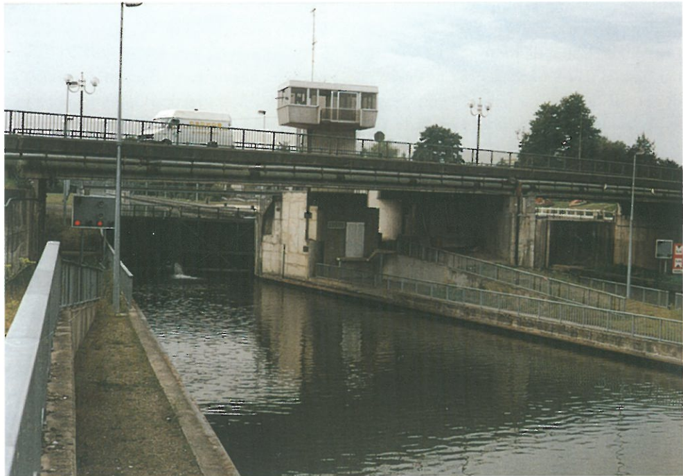
Bild 5.4–36 Großschiffahrts- schleuse (links) und Schleuse des Ostka- nals (rechts) an des- sen Abzweigung von der Mosel bei Toul
