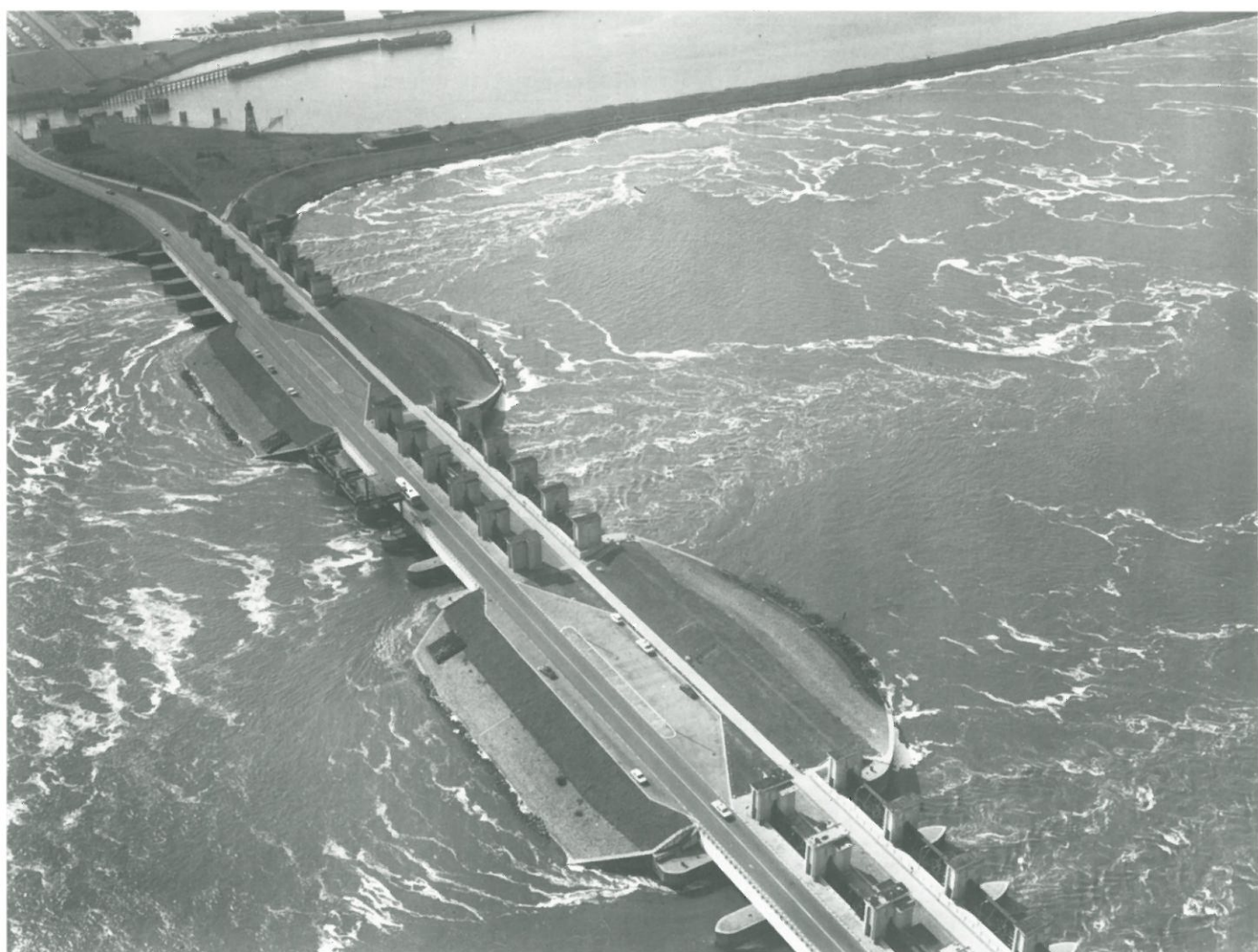
Bild 5.6–11 Ablaßbauwerk und Schleuse im Ab- sperrdamm der Zui- derzee bei Den Oe- ver
