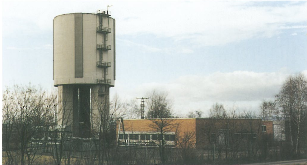
Bild 3.11 Beregnungspumpwerk am Otterstädter Altrhein südlich Ludwigshafen. Rechts Wasserschloß und Pumpwerk, unten Einlauf.
