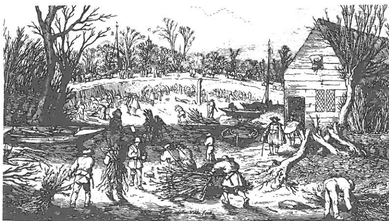
Bild 4.14 Wiederherstellungsarbeiten nach einem Bruch des Lekdeiches am 10.1.1624
