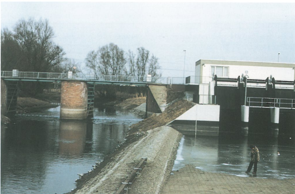
Bild 5.3–18 Schwarzbachschöpfwerk bei Ginsheim
