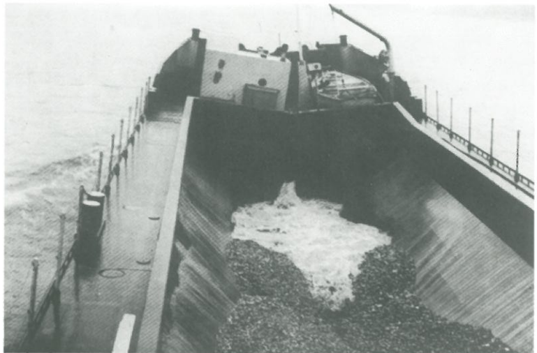
Bild 5.2-15 Entleeren der Klappschute zur Geschiebezugabe
