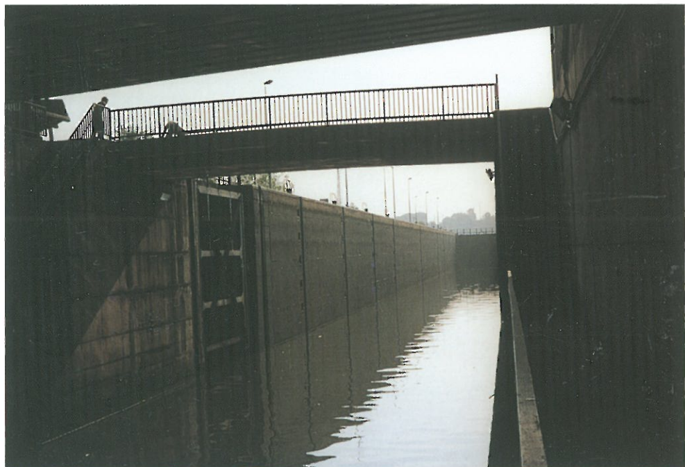
Bild 5.4–33 Die oberste Groß- schiffahrtsschleuse der Mosel bei Neu- ves-Maisons
