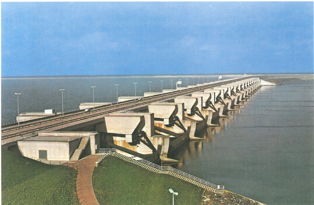
Bild 5.6–19 Ansicht der Auslässe im Haringvlietdamm
