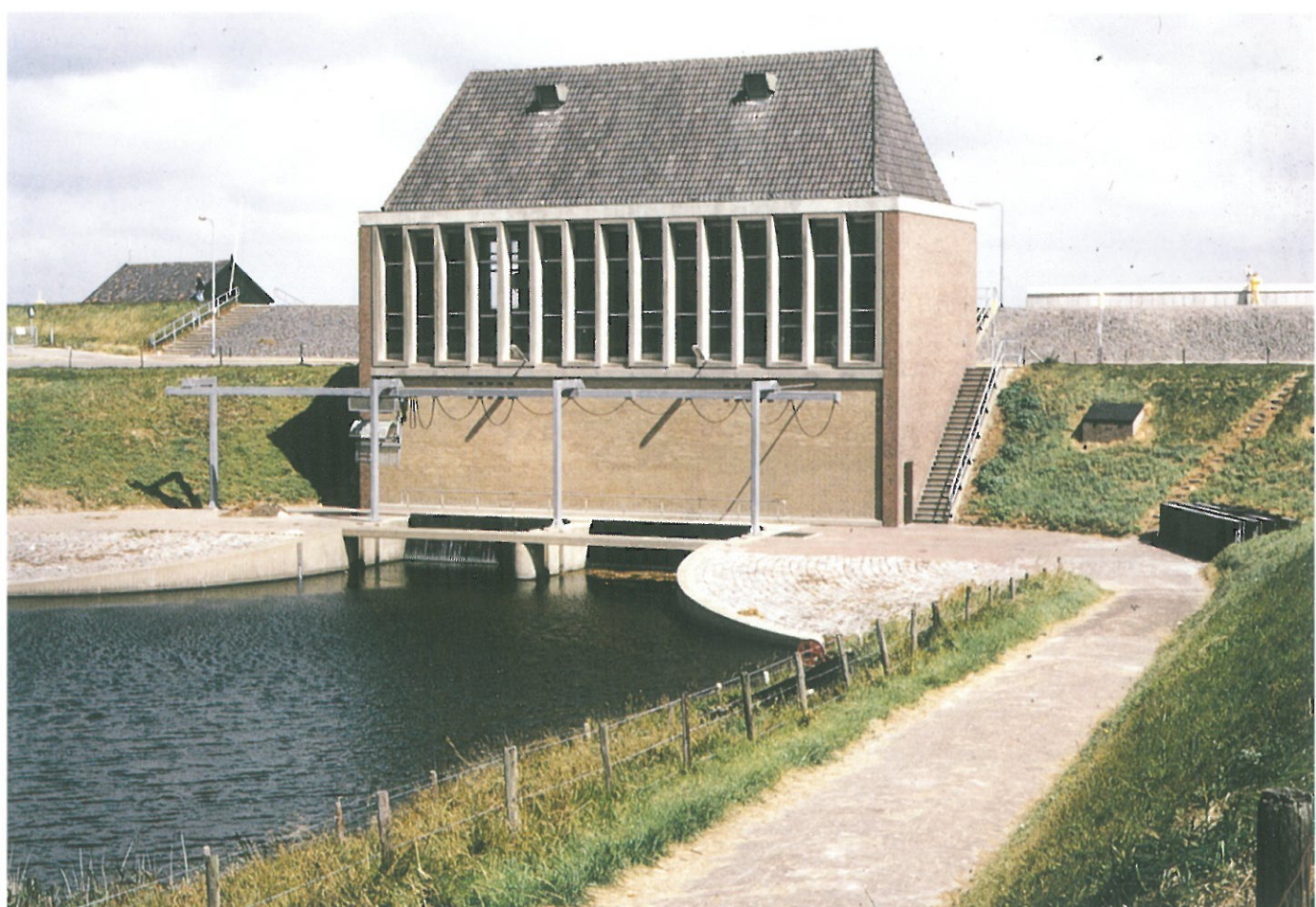
Bild 5.6–24 Modernes Schöpfwerk an der Küste, Ansicht vom Binnenland
